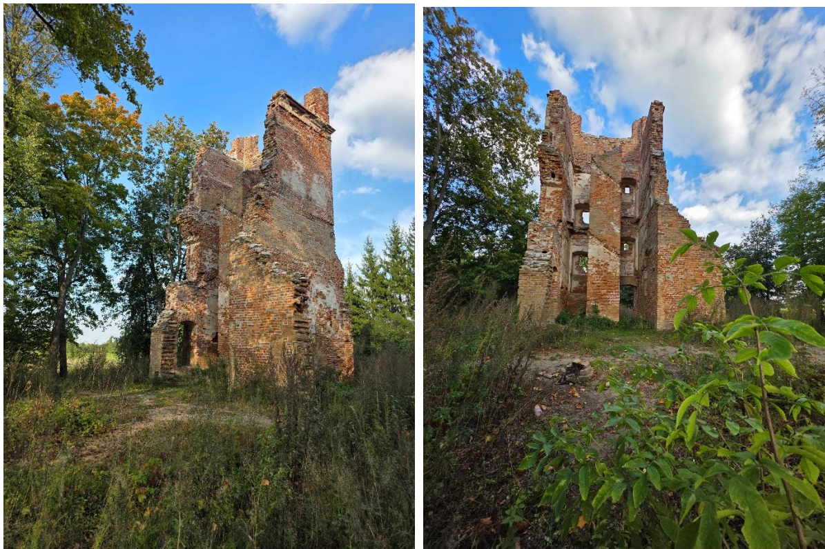
Zdjęcie 6. Dokumentacja fotograficzna obszaru zdegradowanego - Ruiny Pałacu Biskupów Płockich w Broku
