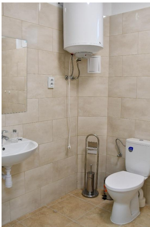
Łazienka w budynku świetlicy w Bojanach.
