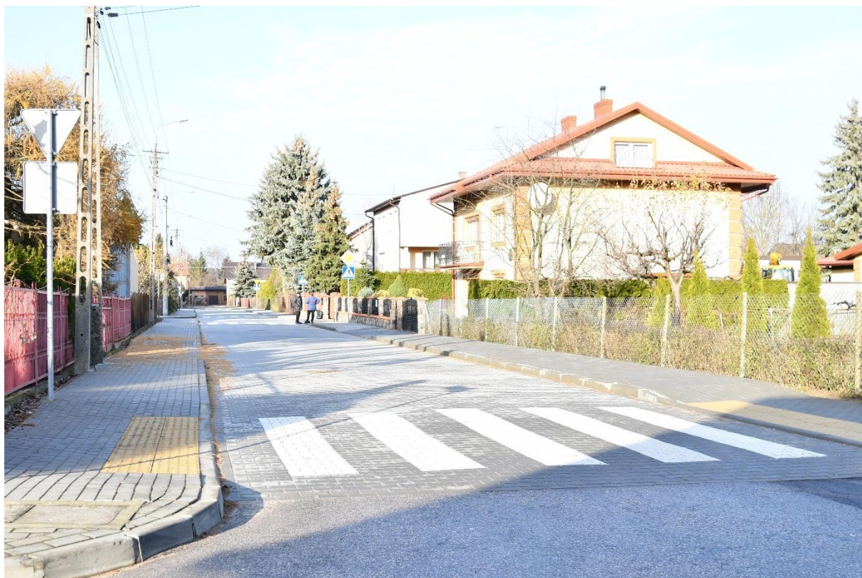
Przebudowa dróg gminnych ul. Strażackiej, ul. Wyzwolenia ul. Wójcickiego i ul. Cichej.
