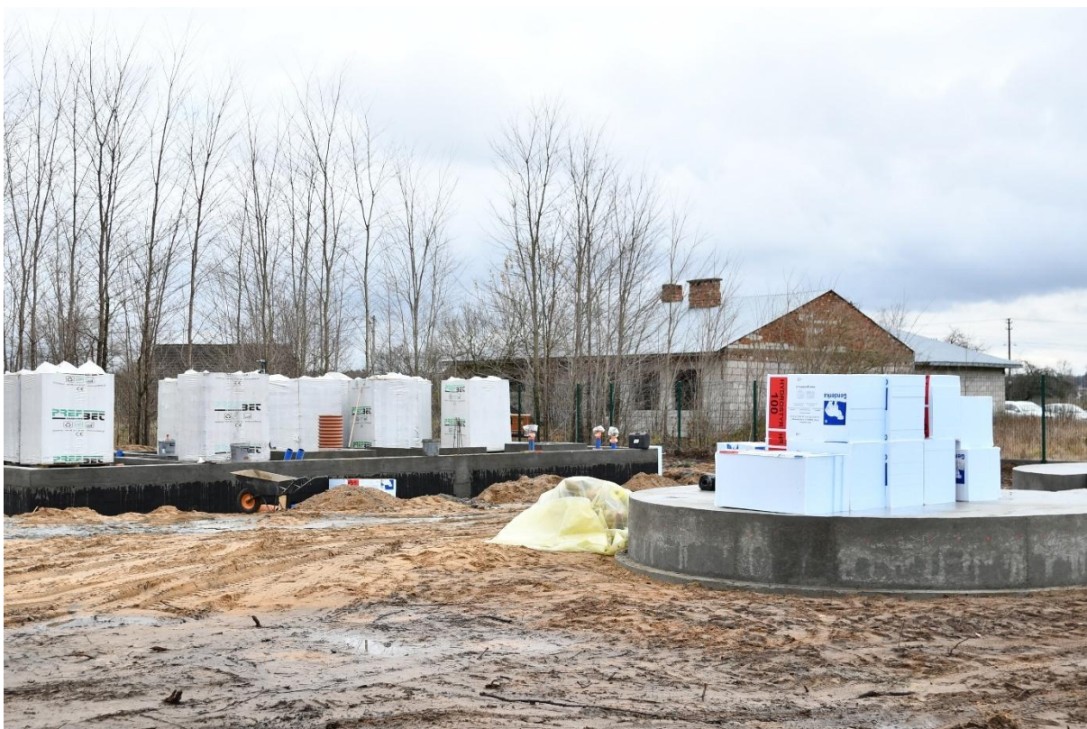
Budowa Stacji Uzdatniania Wody w Kaczkowie Starym
