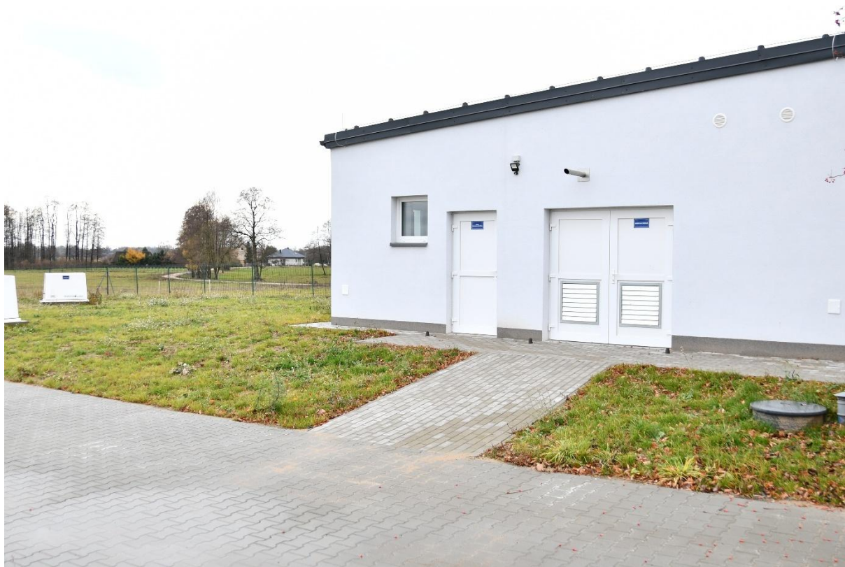
Hydrofornia w miejscowości Bojany.
